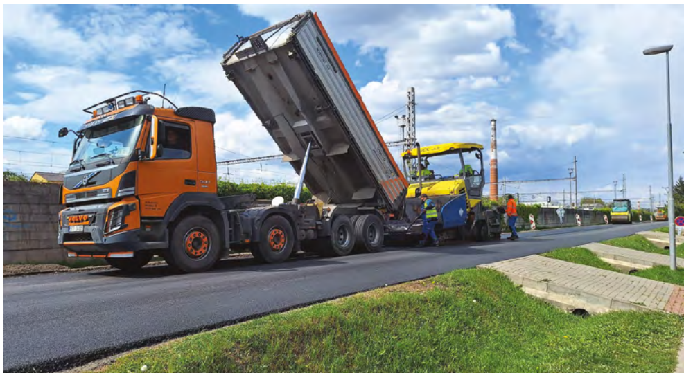
Oprava povrchu vozovky na ulici Nádražní.
